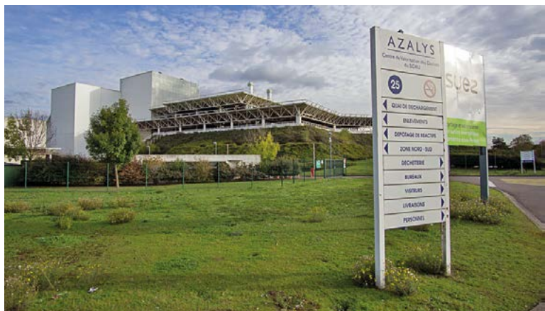
Formé par 15 communes, le Syndicat intercommunal de destruction des résidus urbains (Sidru) est propriétaire de l'incinérateur carriérois Azalys.
